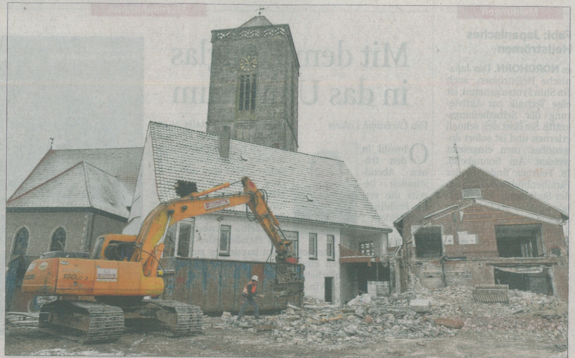
Ein Abrissbagger ist derzeit im Ortskern von Veldhausen im Einsatz.
